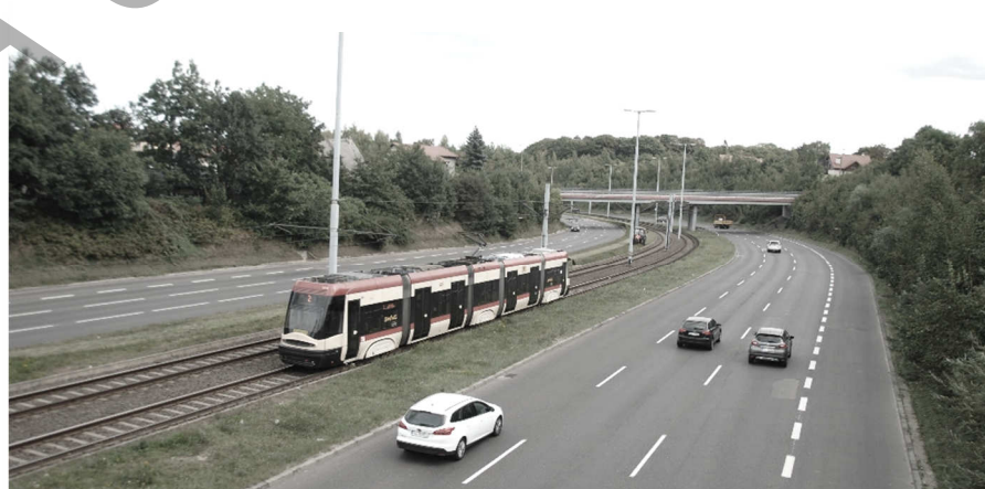
fot. 15. Jezdnia w ulicy o wyższej klasie technicznej spełnia przede wszystkim rolę transportową. (Źródło: BRG)
