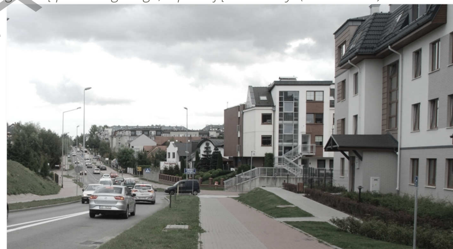
fot. 25. Różnica poziomów między chodnikiem, a wejściem do budynku. (Źródło: BRG)
