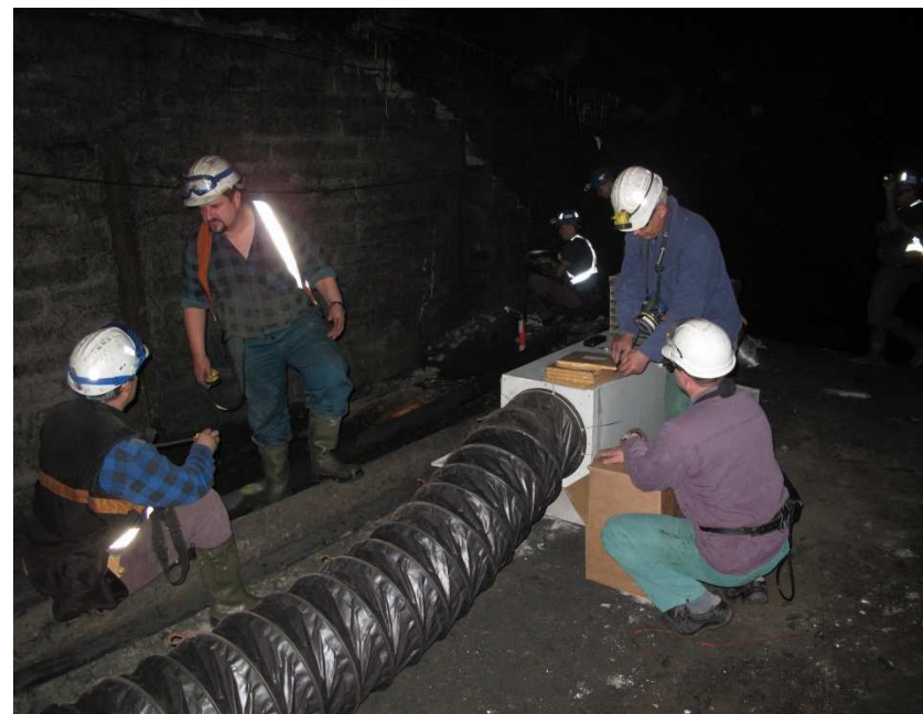
Montaż urządzenia z matami żelowymi
