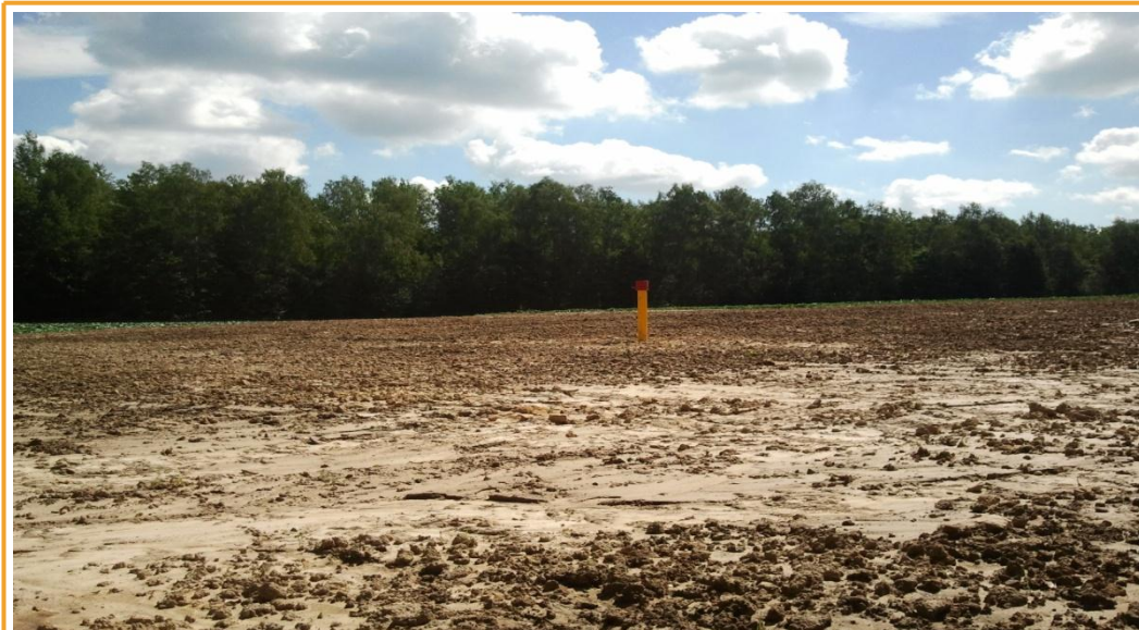
Obszar po rekultywacji z pozostawionym piezometrem badawczym.
