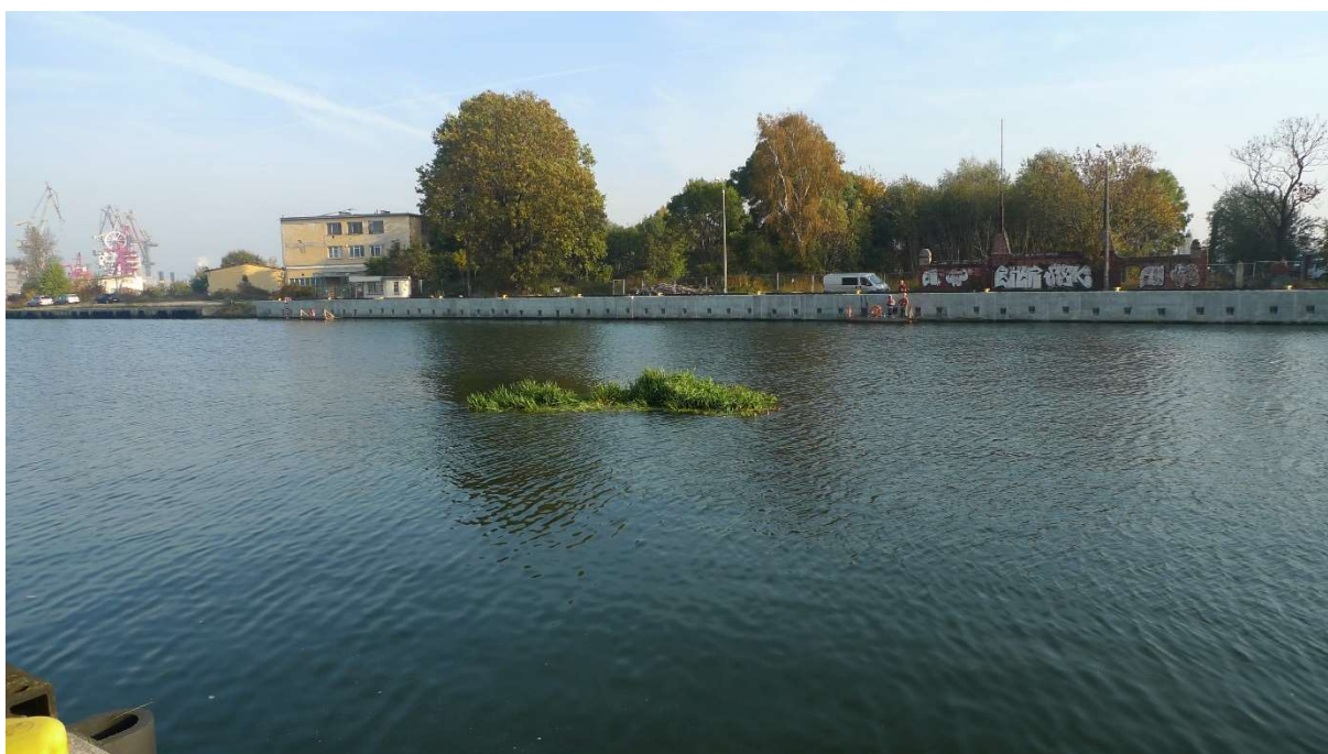
il. 15. Budowa nabrzeży na Polskim Haku (fot. BRG).
