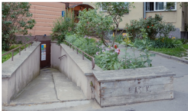
→ ul. Toruńska 6 (zsyp/rampa)
