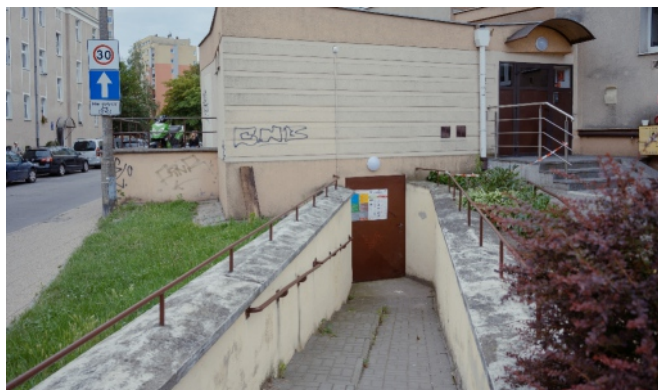
→ ul. Toruńska 8 (zsyp/rampa)
