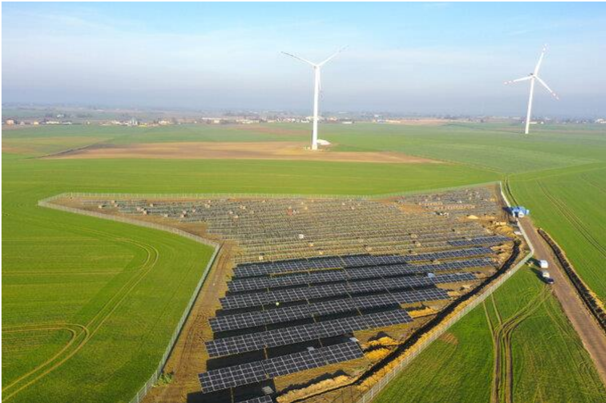
Młynów Szczepanki photovoltaic farm
