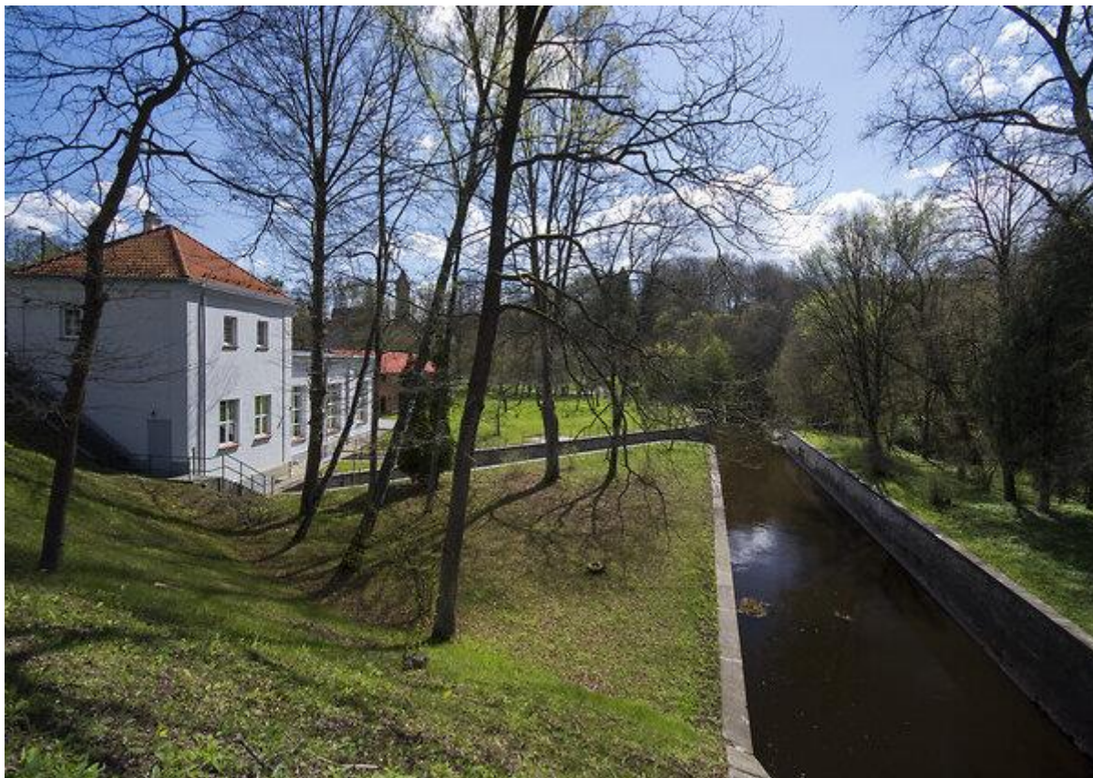
Elektrownia wodna Pieniężno
