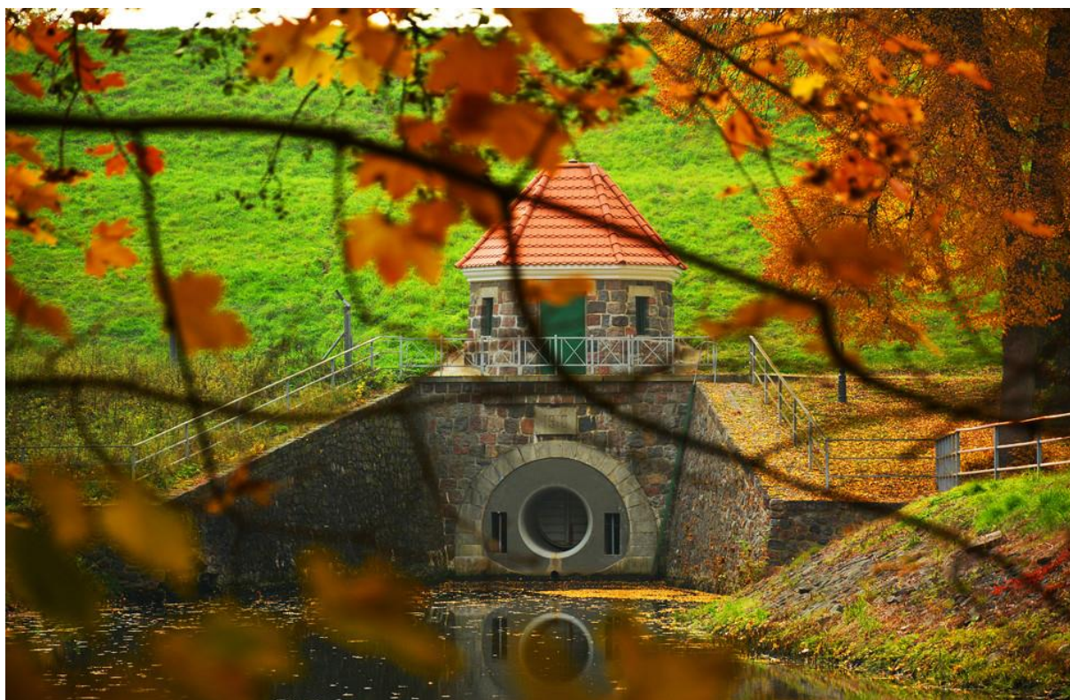
Elektrownia Wodna w Straszynie
