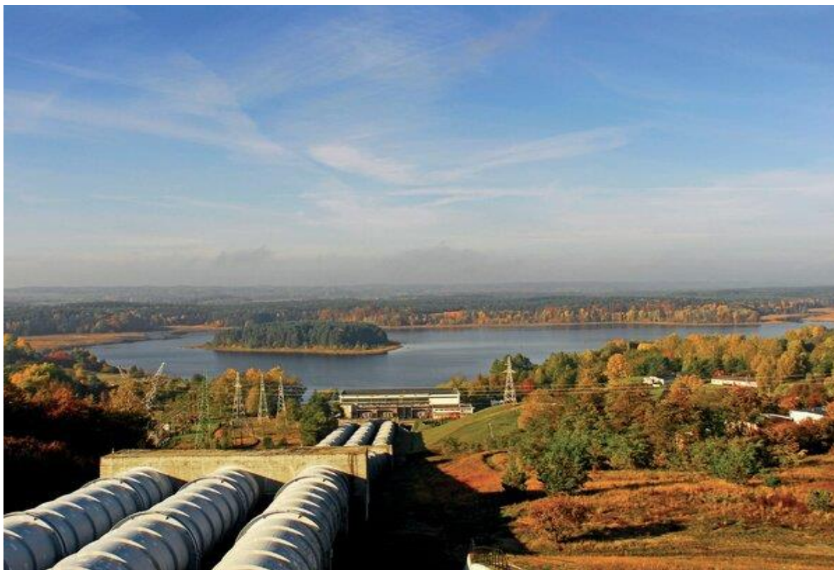
Elektrownia szczytowo-pompowa Żydowo
