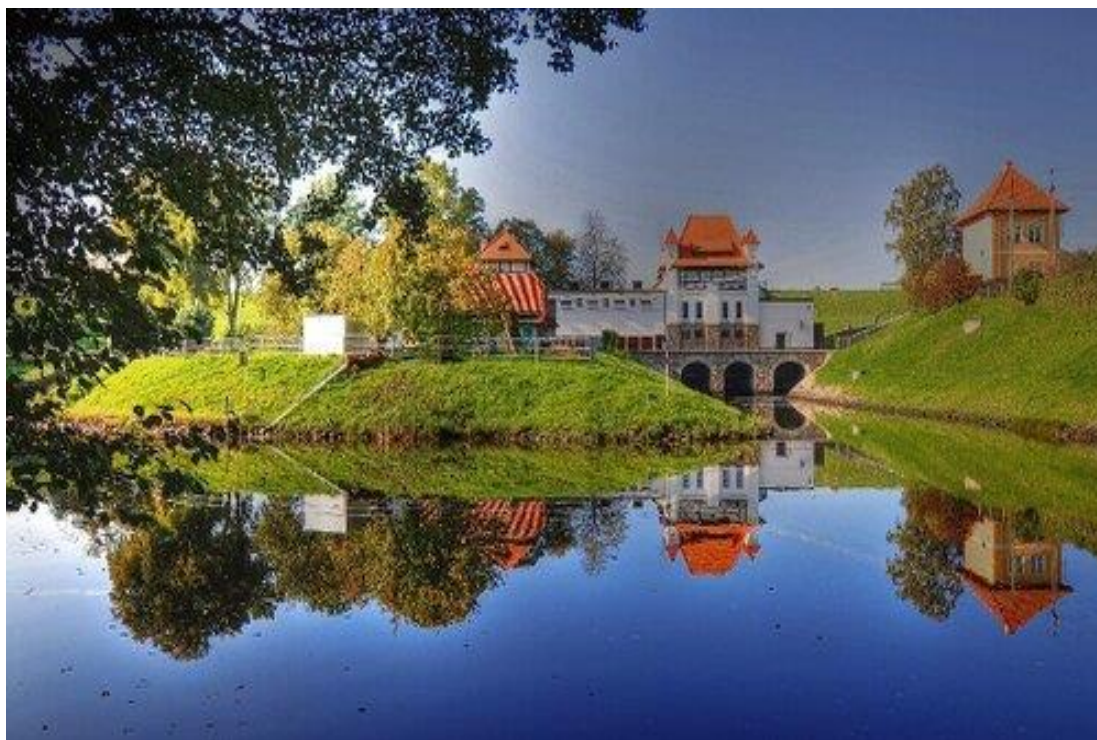
Elektrownia Wodna w Straszynie
