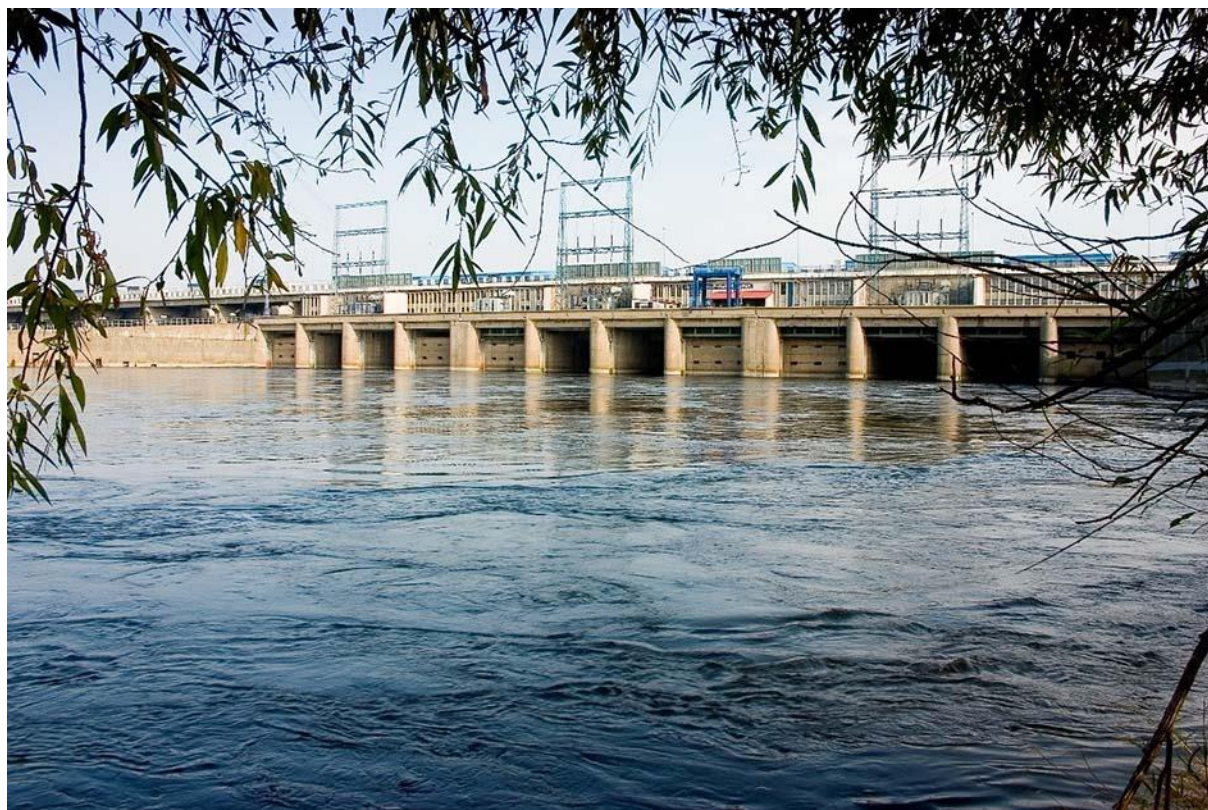
Elektrownia Wodna we Włocławku
