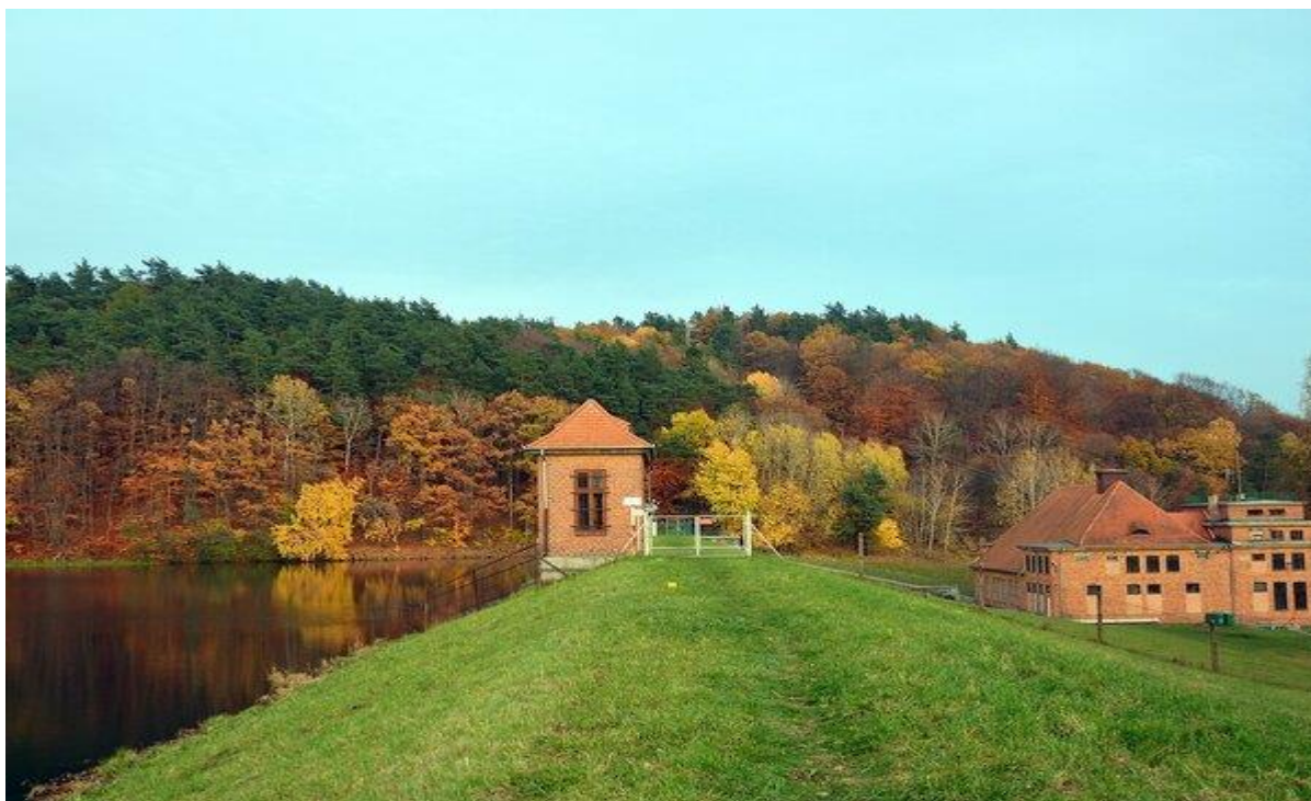
Elektrownia Wodna w Łapinie
