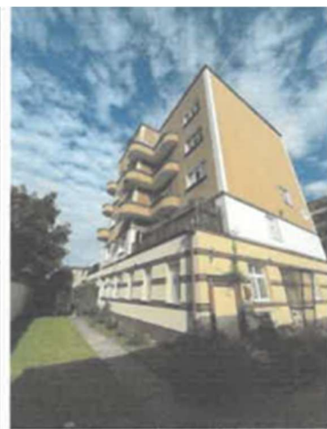
Widok na budynek do strony wschodnio-południowej
