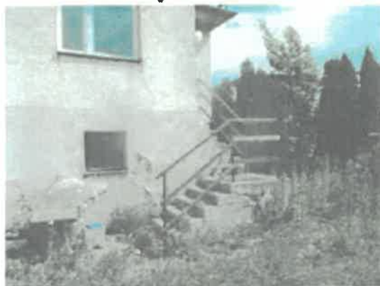
Wejście do budynku.
