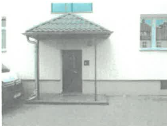
Wejście do budynku.
