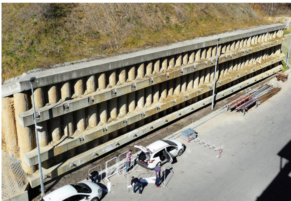
Obecnie nie ma praktycznie żadnej dużej inwestycji miejskiej realizowanej bez potrzeby wykonania głębokich wykopów.
