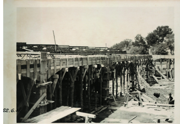
Schaling des Mittelbalkens in der Parterredede.
