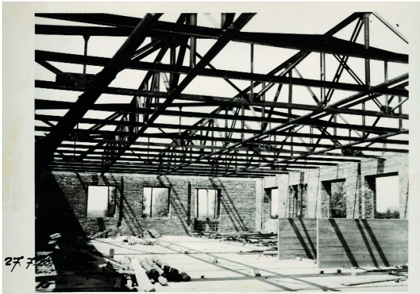
Eisenkonstruktion der Daches über dem Bürogebäude
