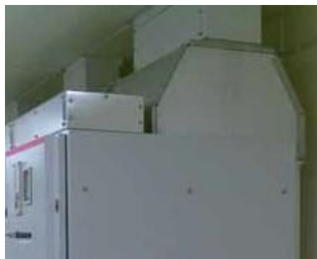
Przykład rozdzielnic wyposażonej w kanał gazowy z ujściem (całkowita wysokość rozdzielnic wynosi 2675 mm w przypadku rozdzielnic 12–17,5 kV do 40 kA)
