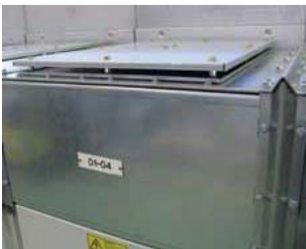
Przykład rozdzielnic wyposażonej w kanał gazowy z górnymi kominami (całkowita wysokość rozdzielnic wynosi 2530 mm w przypadku rozdzielnic 12–17,5 kV do 40 kA)
