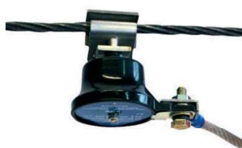
ogranicznik ASA z odłącznikiem w trakcie normalnej pracy
