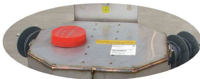
Fot. 1.1 Zawór bezpieczeństwa z pokrywą
