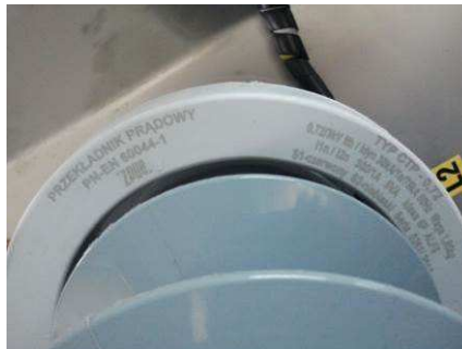
Fot. 3.2 przekładniki prądowe typu CTP-0,72
