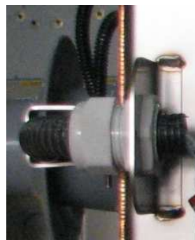
Fot. 3.6 Sensory napięciowe przyłączone do ograniczników przepięć UZW...
