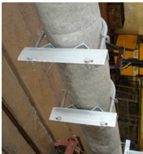
Rys. 5.1 Przykład zamocowania konstrukcji pod rozłącznik THO lub szafę SO na stanowisku z żerdzi E i EM
