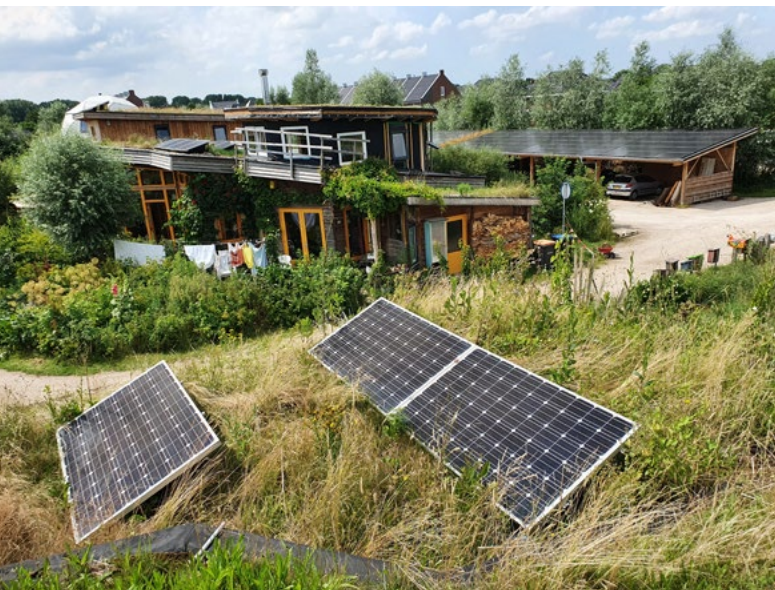
Fotowoltaika na zielonym dachu domu w Aardhuizen [C.Gercek, 2021].
