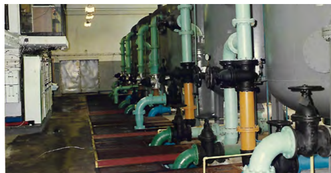
Hala z aeratorami i filtrami w N-BSW SGGW przed remontem (fot. D. Morawski)
