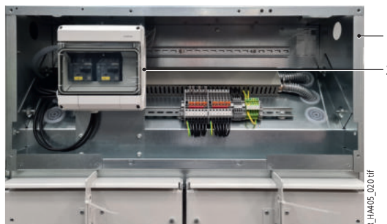
Wnęka niskiego napięcia pomiarowego pola rozliczeniowego typu M z otwartą pokrywą
