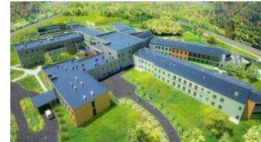
Infrastruktura Szpitala w Drewnicy
