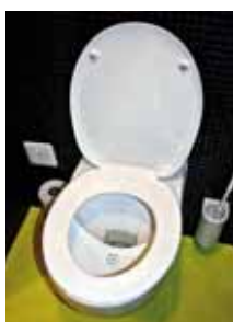
Charakterystyczne toalety z rozdzielczym systemem gromadzenia uryny (www.eawag.ch)
