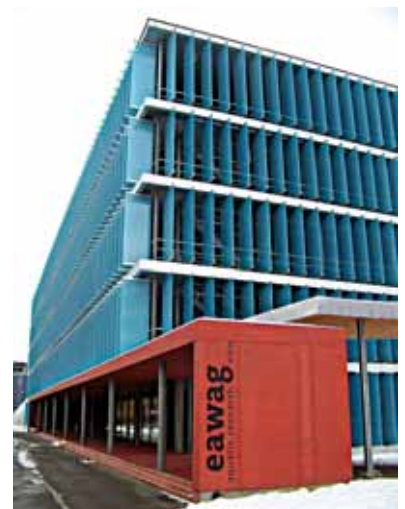
Budynek Eawagu – na zdjęciu charakterystyczne niebieskie szklane żaluzje jako system chłodzenia budynku (fot. A.E. Sikorska)
