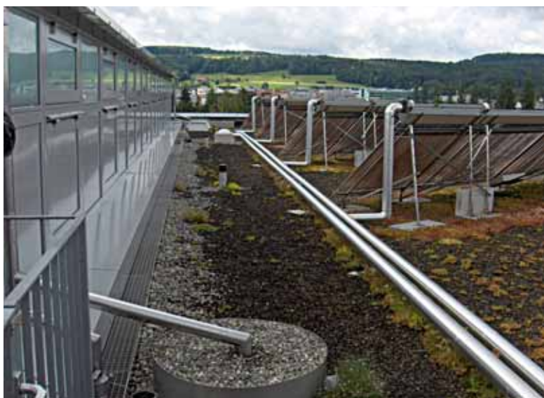
Zielony dach budynku Eawagu wraz z widocznym systemem przechwytywania wody deszczowej (www.eawag.ch)
